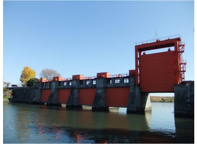
旧岩淵水門(赤水門)
