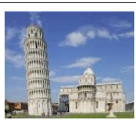
ピサ大聖堂の鐘楼。高さ56m。階段299段。傾斜5.5度まで傾いていたが1990~2001年の工事により3.99度まで、是正された。世界遺産。
