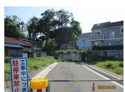
工事中断の川名工区
