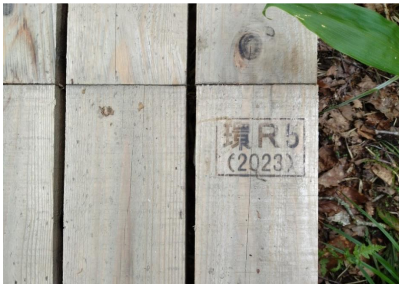
この木道は環境省が令和5年に設置したもの 材は国産のカラマツを使用し、耐用年数約10年、費用は距離1m辺り約10万円かかる。総延長65kmに達する
