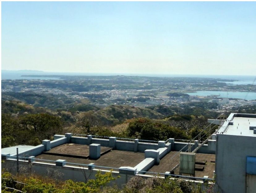
見晴らしは抜群で、半島の全景が見渡せる。手前の建屋は NTT の通信施設
