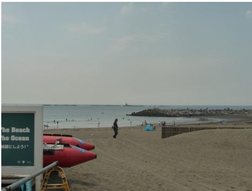
「ヘッドランド」1991年海岸の砂の浸食を防ぐため、石垣で築いた人口の岬。後方の烏帽子岩を見ながら、家族で海水浴が楽しめるようになった。
