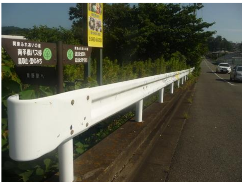
バス停には関東ふれあいの道案内板と、道標が整備されている
