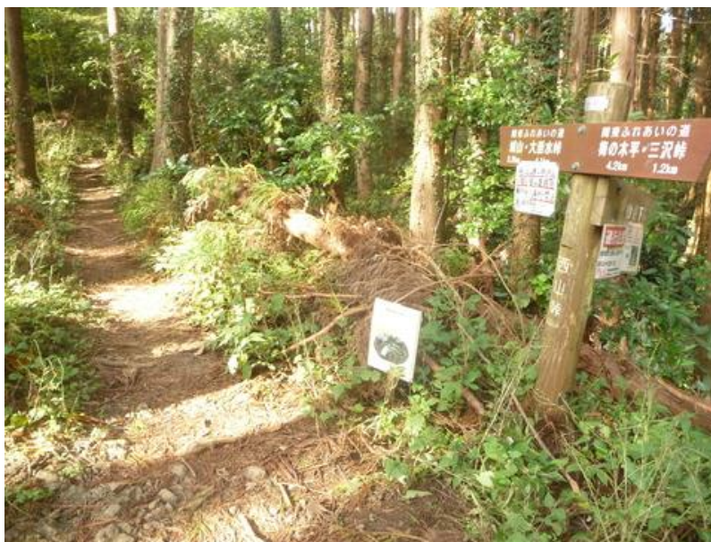
「西山峠」峠に差し掛かったら、この先通行止の表示が出た、がけ崩れの表示。
