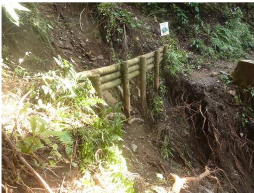
台風 19 号の影響でがけ崩れが発生した、急遽巻き道が出来たので無事通過する
