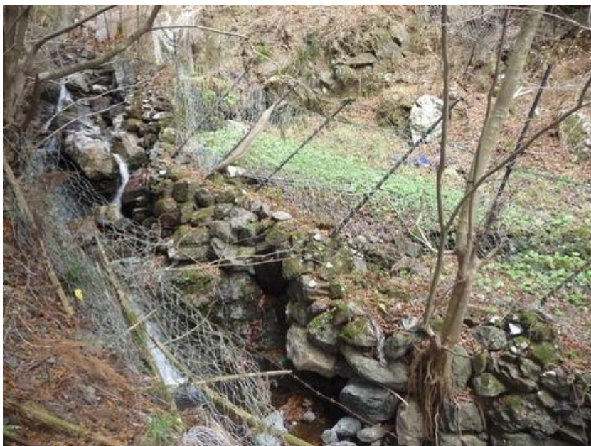
わさび畑は残るが、ほとんど先の台風で沢は削られ、壊滅している
