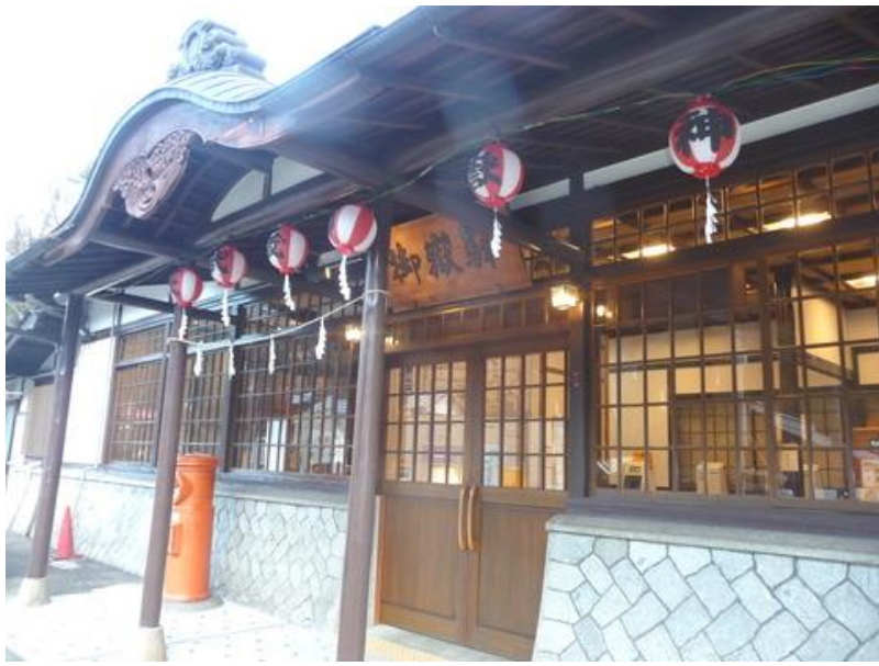
御嶽駅は関東一の道場である御嶽山神社の玄関口であるから、駅舎の造りも神社風だ
