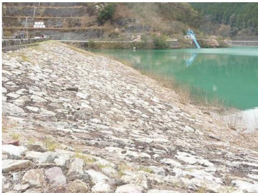
「有馬ダム」入間川の支流有馬川を堰き止め、昭和 61 年 3 月に完成したロックフィルダム。灌漑・治水、また飲料水の確保をも目的として造られた。
