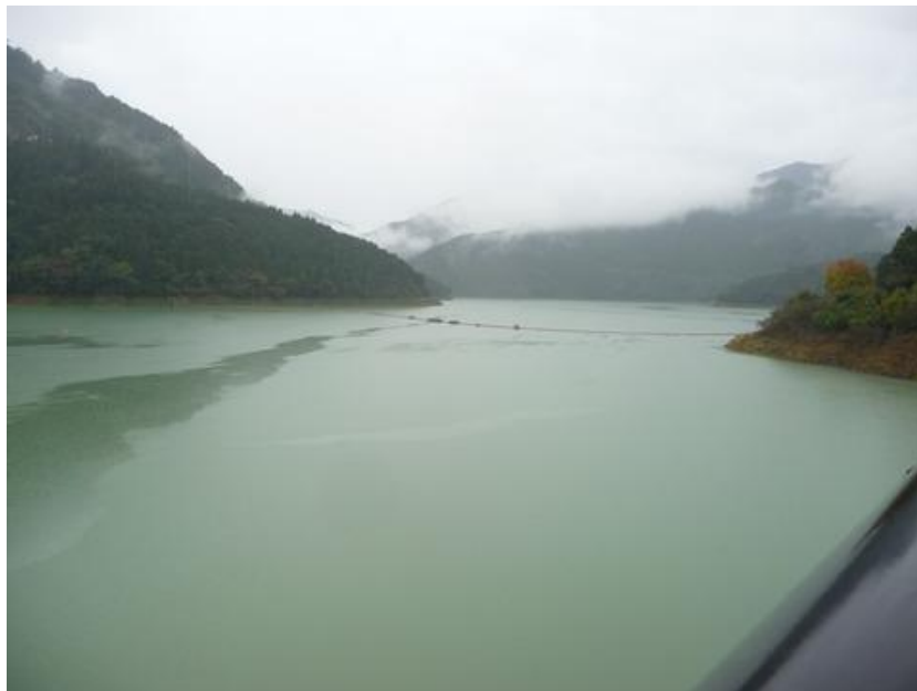
直線重力式コンクリートダムで洪水、灌漑、水道、発電等目的とする多目的ダム毎秒 14 トンの水を水道水として埼玉・東京に送る
