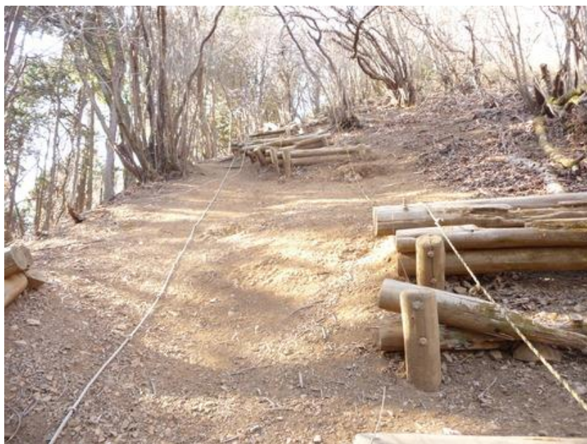
木枕が崩れ去り、急な泥尾根にはロープが垂れ下がる
