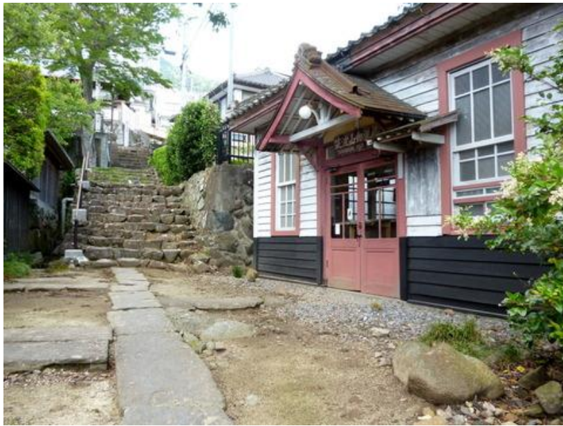
昭和 14 年建てられた筑波郵便局旧庁舎を、平成 20 年ここに移築して展示している
