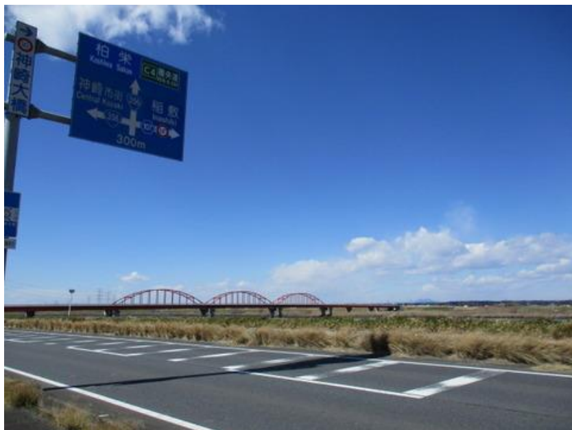
神崎大橋の赤いアーチが見えてくれば、ゴールは近い
