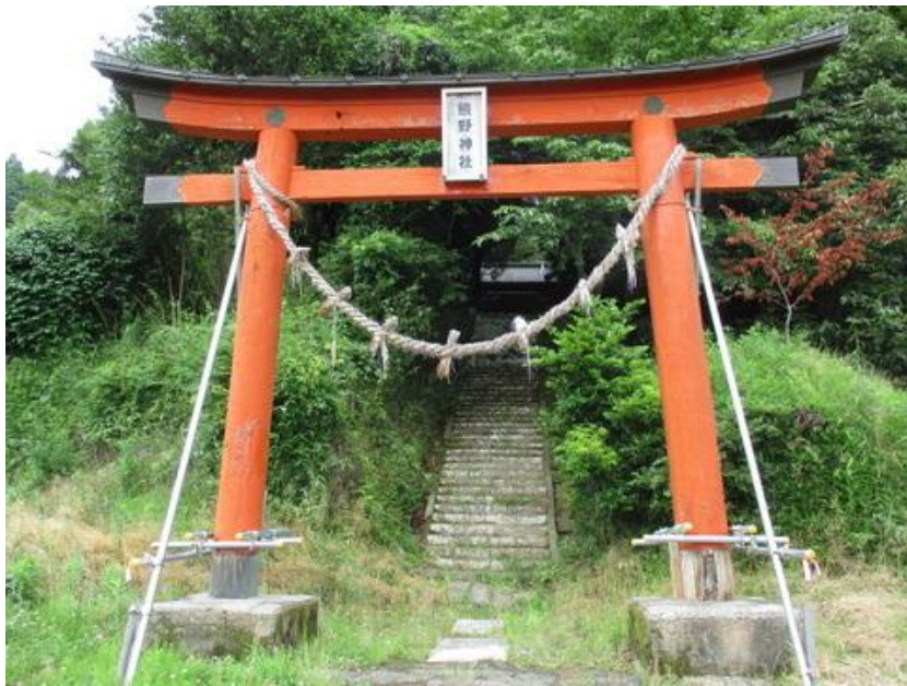
砂田（いさごだ）集落の産土であろう、鳥居の根元が腐りかけている
