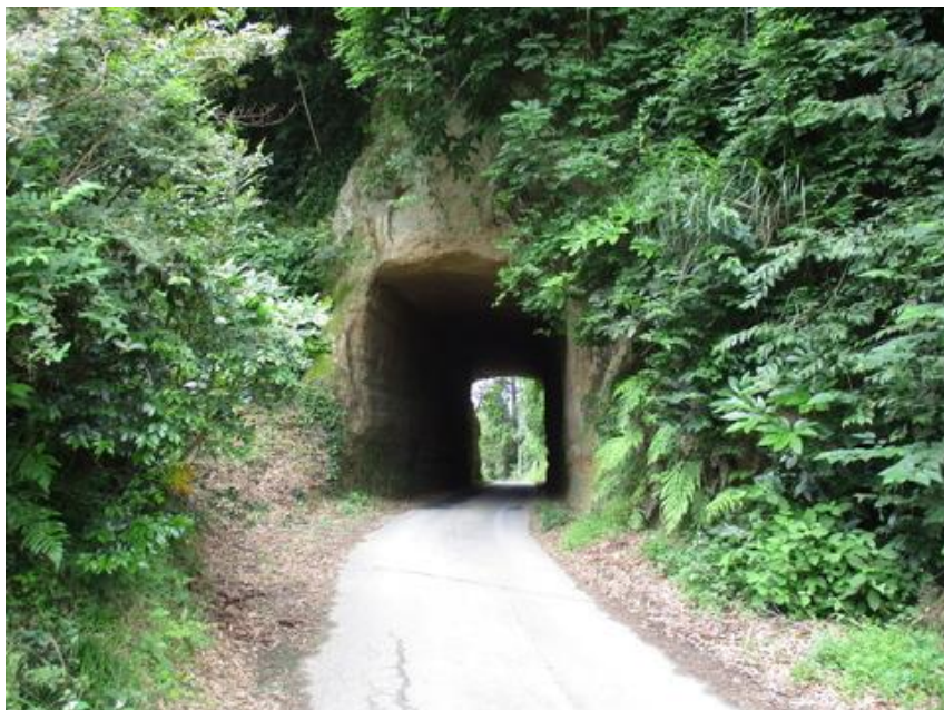
砂田集落を通過するには、三方が丘陵となっているから、トンネルを通過して隣村に入る
