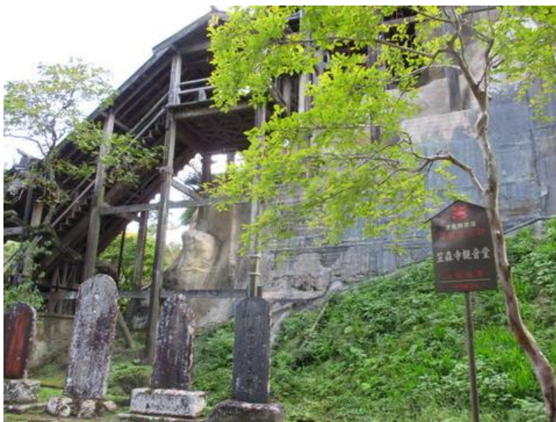
観音堂は長元元年(1028)後一条天皇の勅願により建立された、日本唯一の「四方懸造り」として国指定重要文化財となっている
