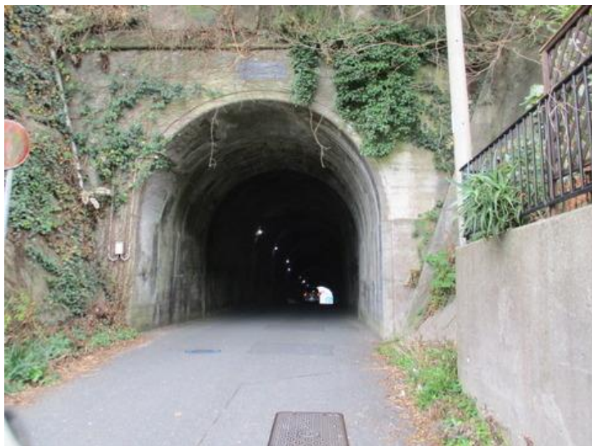
一旦半島の尾根をトンネルで潜り、次の海岸に向かう
