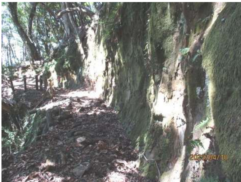
谷側は崖が崩れて足場が危うい
