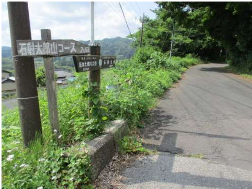
石射太郎山へは崖崩れのため通行止めであるから
