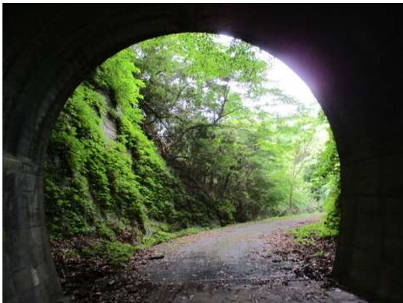
尾根の張り出しには、所どころトンネルで潜り、風景がその都度変わる
