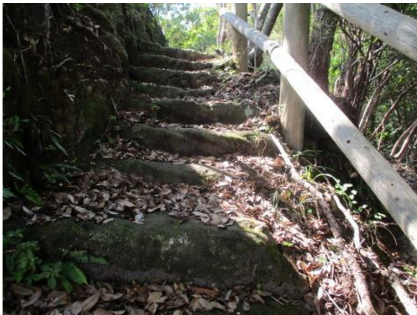
急な斜面には、岩肌に階段が彫り込まれている
