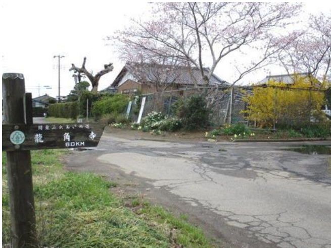
竜台集落は田圃の中の集落で、利根川が氾濫したら、ひとたまりもない低地に位置している
