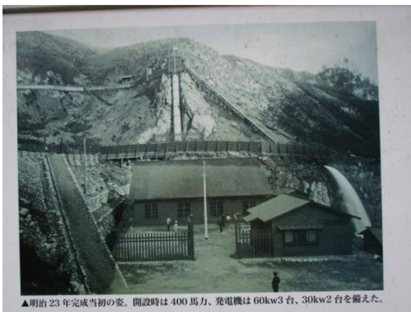
かつての水力発電所(明治23年完成)
