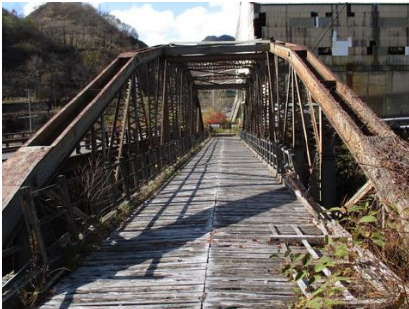
「古河橋」明治 23 年(1890)日本初の鉄道橋。銅、鉄製、床板は木材、橋長 48.5m老朽化の為平成 5 年歩道橋となった
