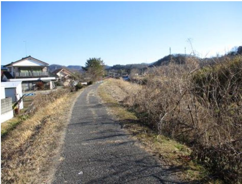
今度渡る川は名草川。この先河川工事中で通行止めであった
