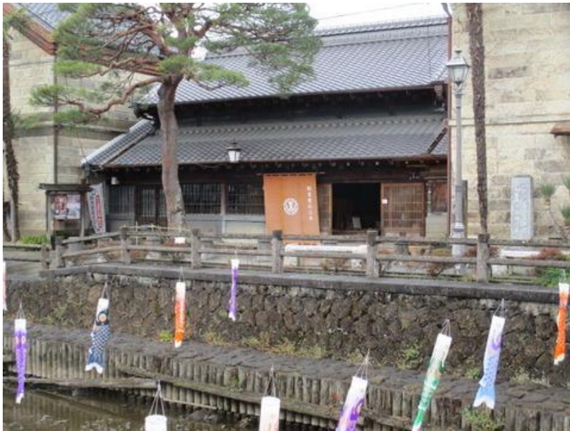
「横山郷土館」(有形文化財)両端を蔵に挟まれた両袖切妻造りの店舗
