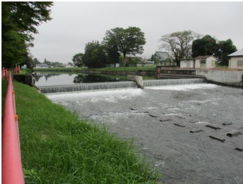
「大前の堰と右側の穴川取水口」ここから桜川集落へ水を通し、コメの収穫を飛躍させた
