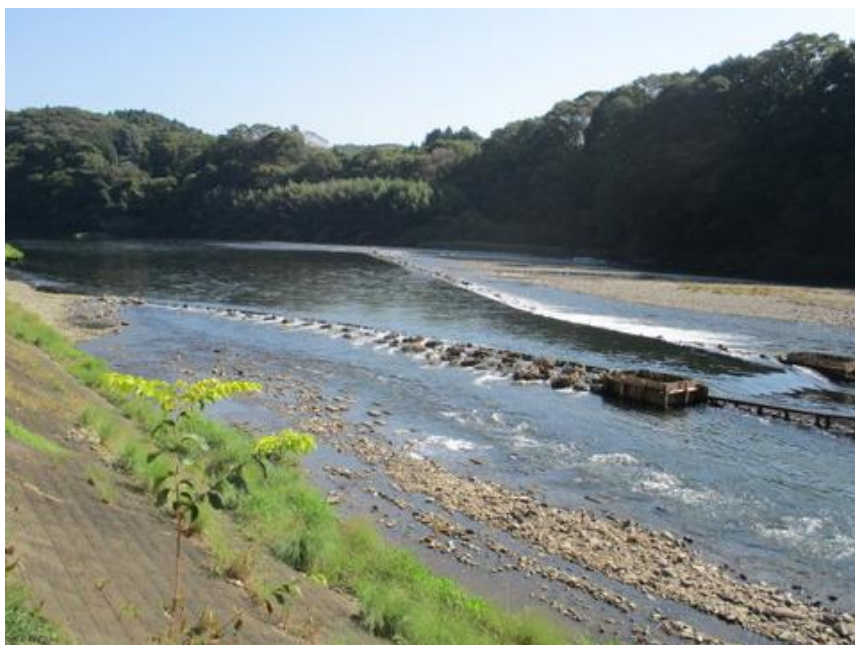
那珂川を半分堰き止めて、鮎を誘導する。
